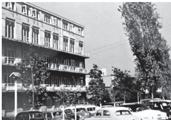
Vista norte del Hospital Clínico de la Universidad Católica.
