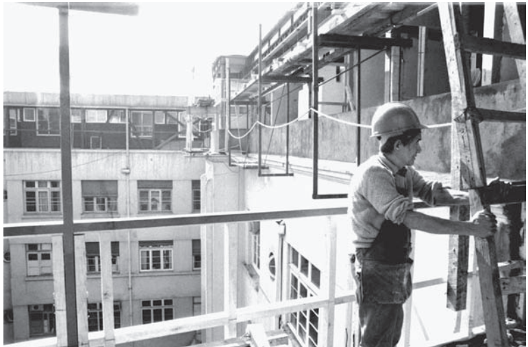
Obras de la segunda ampliación de la Unidad Coronaria, 1989. (Colaboración de la Vicerrectoría de Comunicaciones y Extensión UC)
